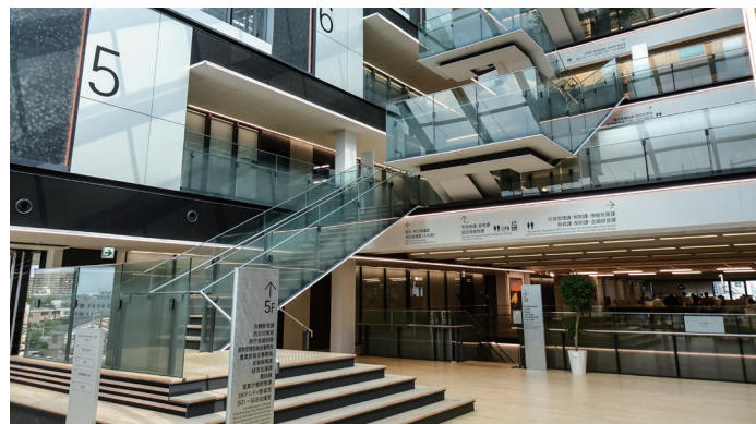
スチール自立ガラス手摺 埼玉県川口市
