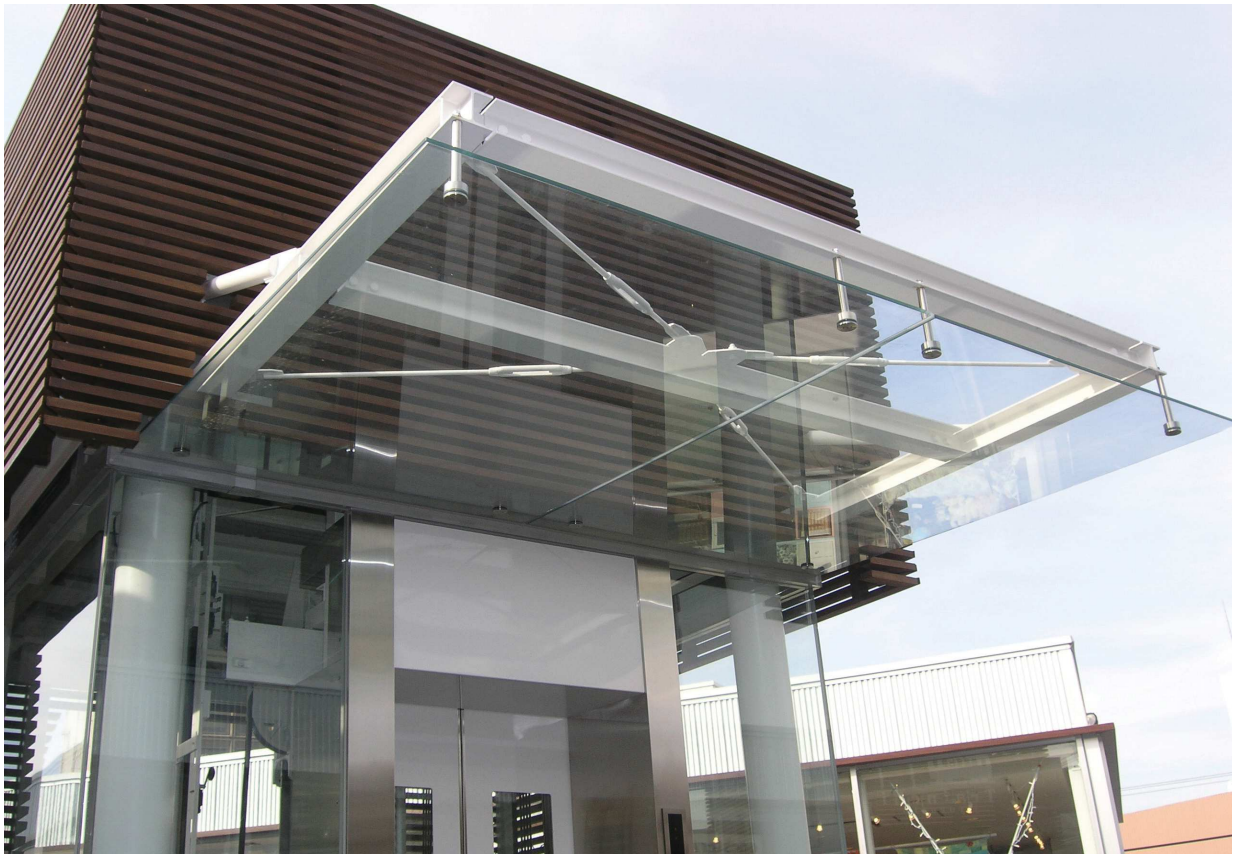
H 鋼 + ステンレス製 DPG 金具 + ガラス製 目黒区
