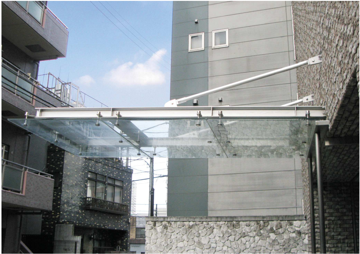
H鋼 + ステンレス製 DPG 金具 + 強化合わせ ガラス製 中野区
