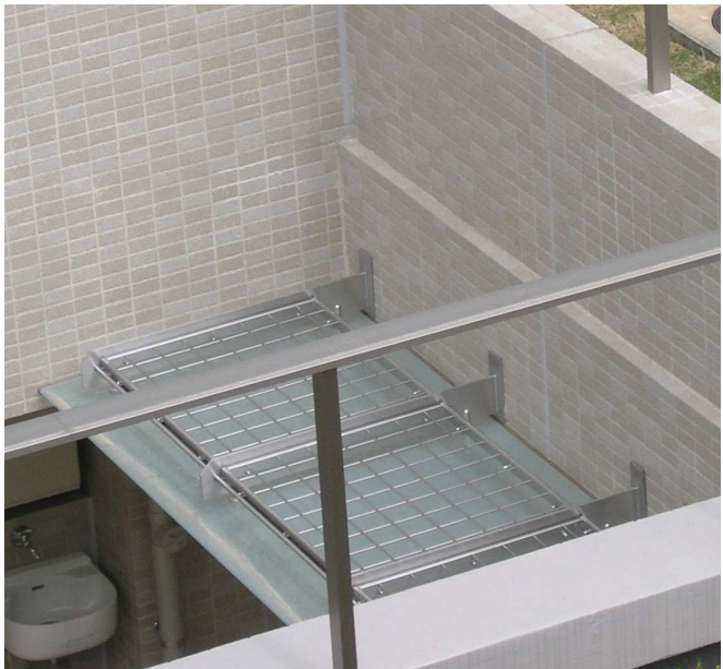
MH-GHP2003 + 落下防止ネット 横浜市青葉区
