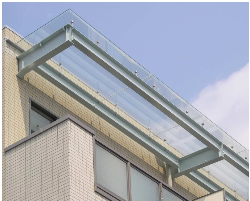
H鋼 + ステンレス製 DPG 金具 + 強化合わせガラス製 中野区
