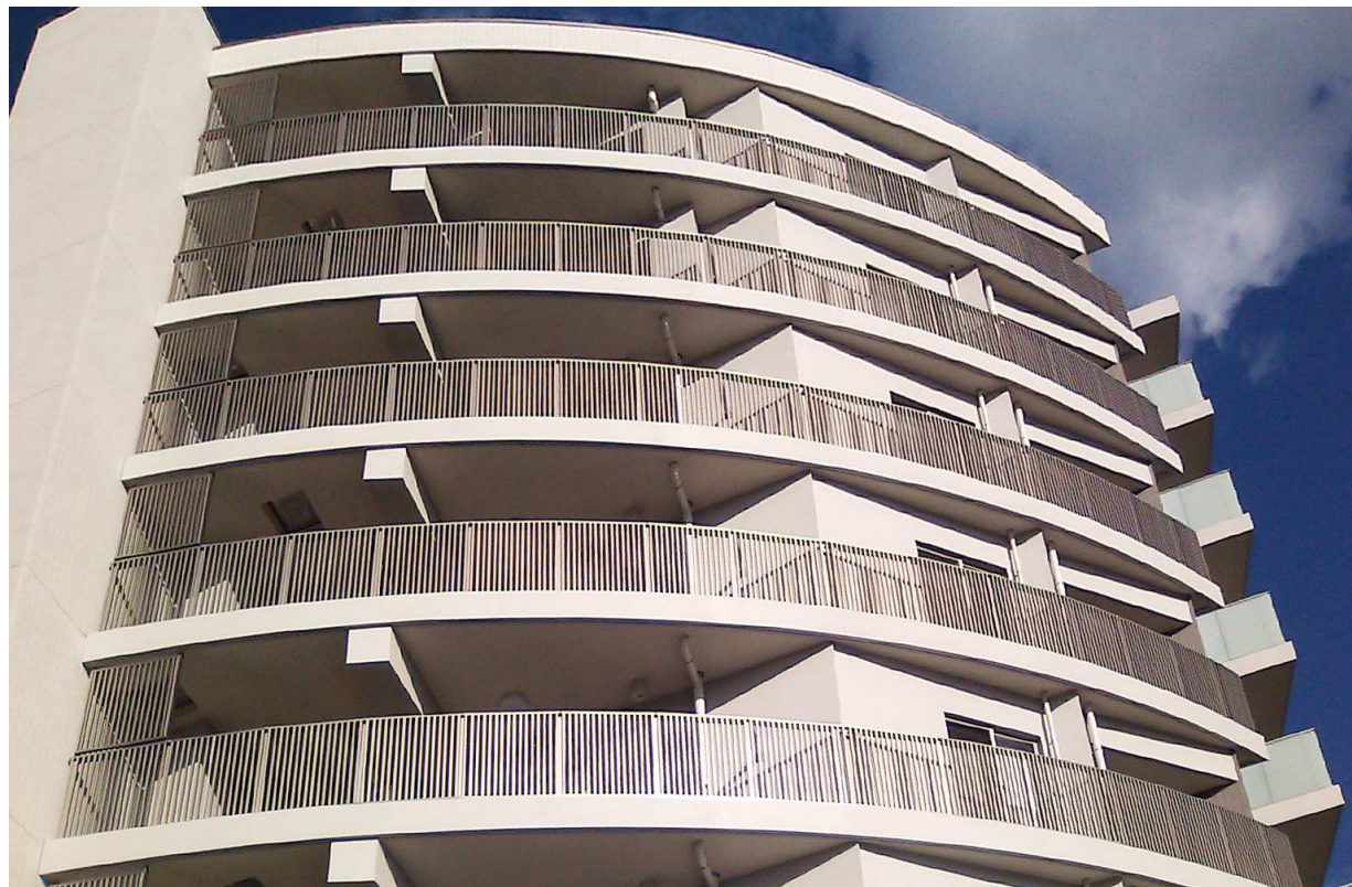
MH-TAK2530K 仙台市泉区
